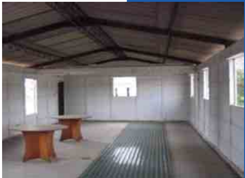
Der zukünftige Unterrichtsraum im Rohbau
